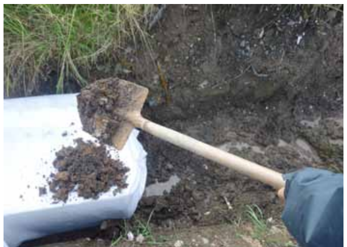
9 Jámu zasypejte původní zeminou hutněnou po vrstvách. Pokud se po zasypání jámě bude chodit, tloušťka vrstvy zeminy je min. 20 cm, pro pojezd aut 60–80 cm a nákladních aut 1 m
