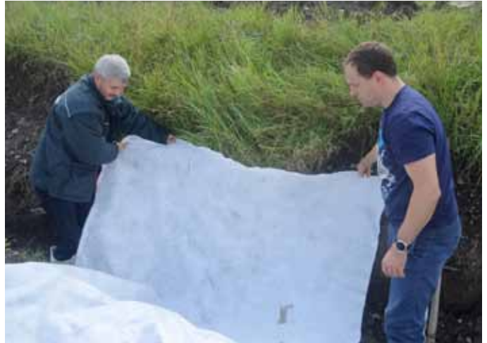
5 Na dno a boky výkopu rozprostřete geotextilii (200 g/m 2 ) k obalení vsakovacích bloků. Bloky lze zabalit i předem vedle jámy
