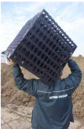
2 Nízká hmotnost vsakovacích bloků usnadňuje manipulaci
