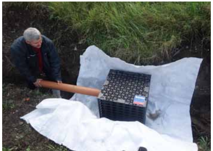
7 Bloky napojte na přívodní potrubí. Potrubí vložte do předem připraveného otvoru, nebo si otvor vyřízněte pilkou
