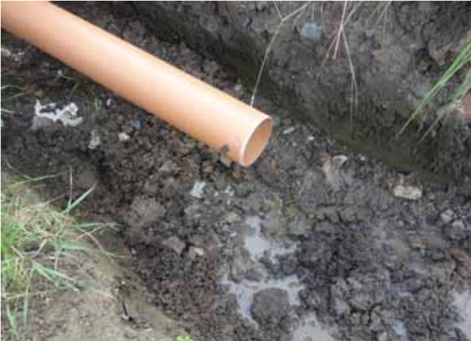
4 Přiveďte přívodní potrubí (navazující na okapy)
